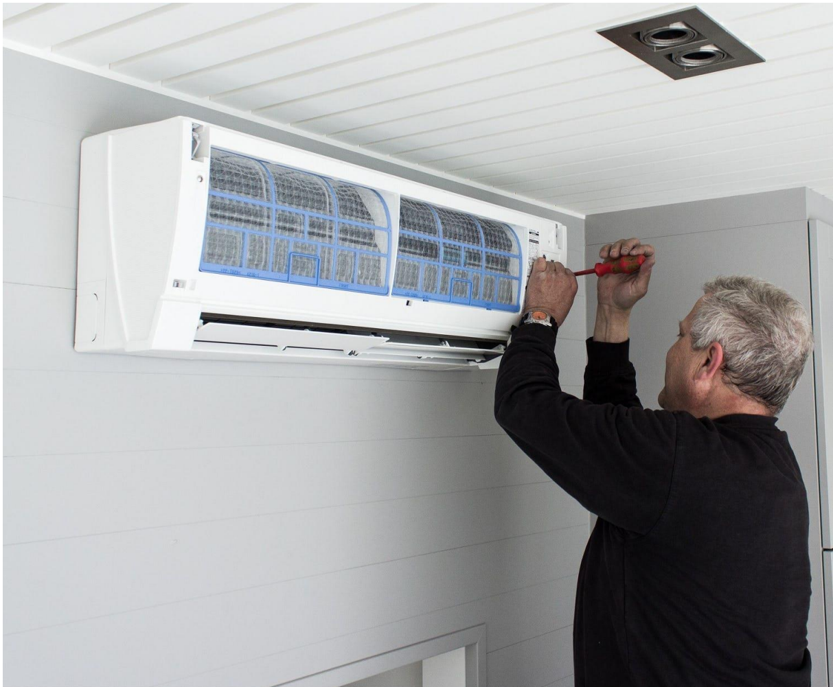
Wand-afgiftesysteem van een lucht/lucht-warmtepomp.
